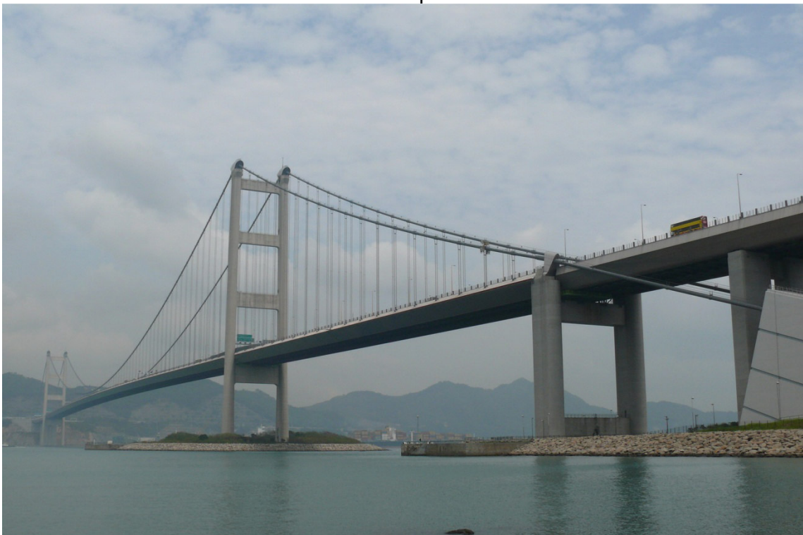
Foto 27: Tsing Ma Brücke
