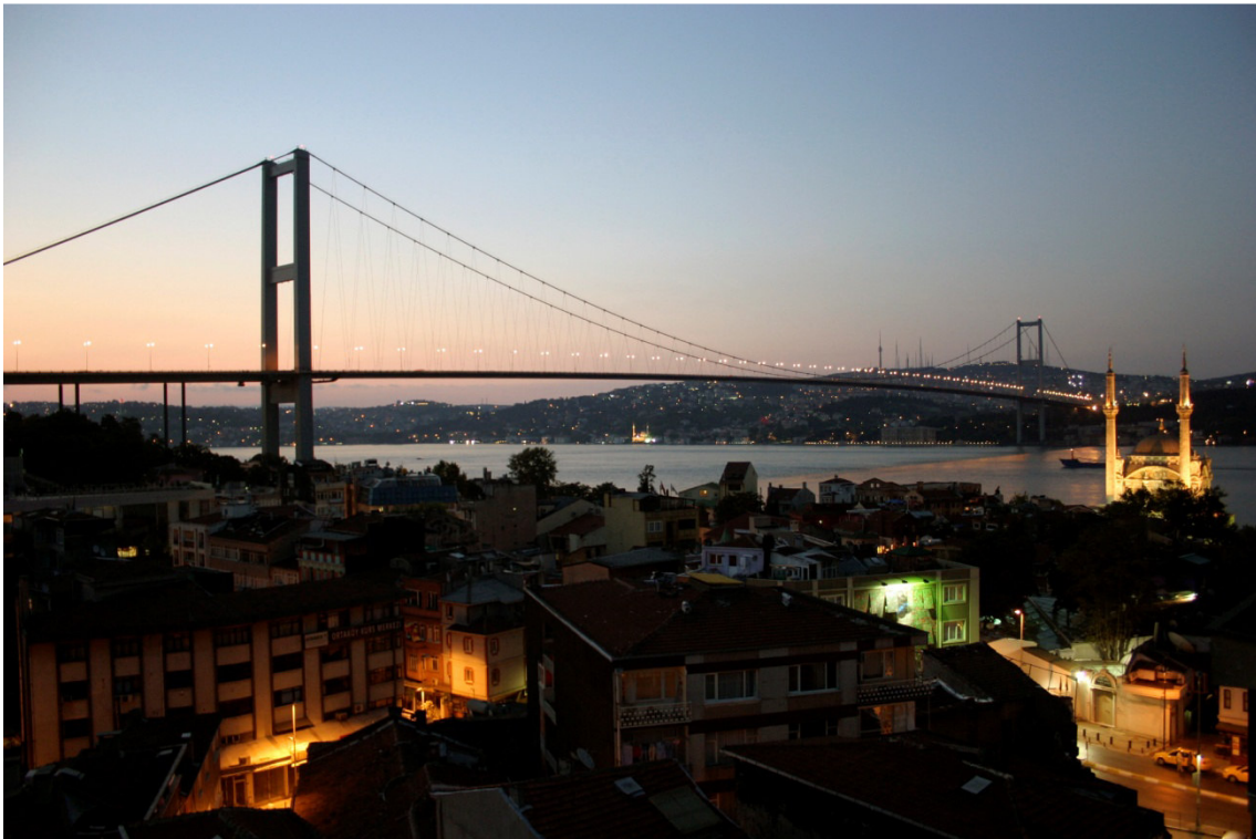
Foto 21: Erste Bosphorus-Brücke, Brückendeck nur 3 m hoch
