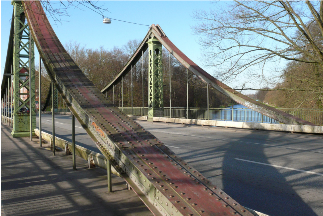
Foto 23: Unechte Hängebrücke: Mühlentorbrücke in Lübeck
