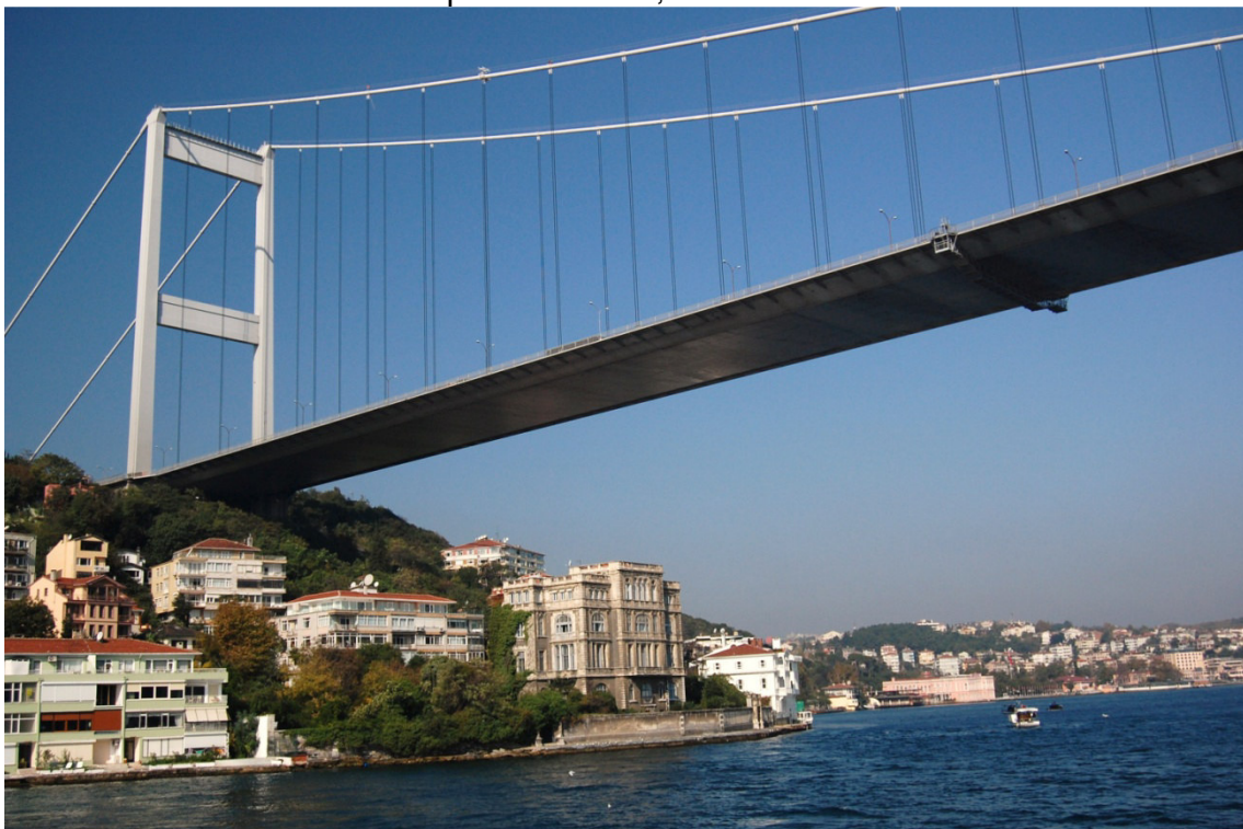
Foto 22: Zweite Bosphorus-Brücke, Pylone stehen am Hochufer
